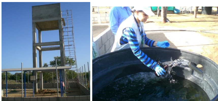
Figura 20. Tanque elevado y toma de muestra de agua pozo profundo, Comunidad Amaichon.
