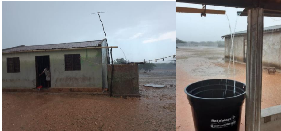
Figura 29. Replica de sistema de captación de aguas lluvias en comunidad Wayuu
