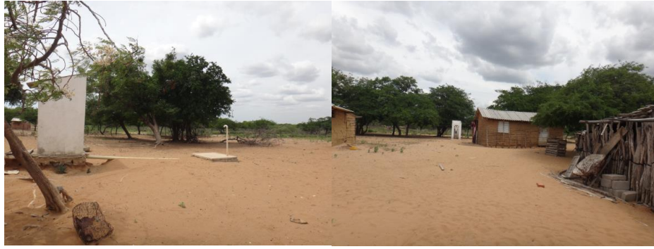
Figura 17. Tanque séptico en comunidad de Amaichon
